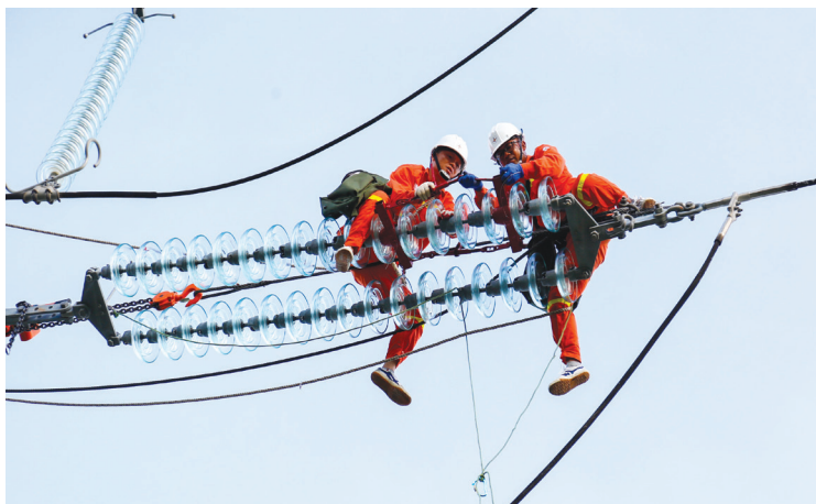
Hội thi thợ giỏi cấp Tập đoàn Điện lực Việt Nam năm 2022 Thi thực hành thay sứ cách điện đường dây 500kV tại hiện trường
