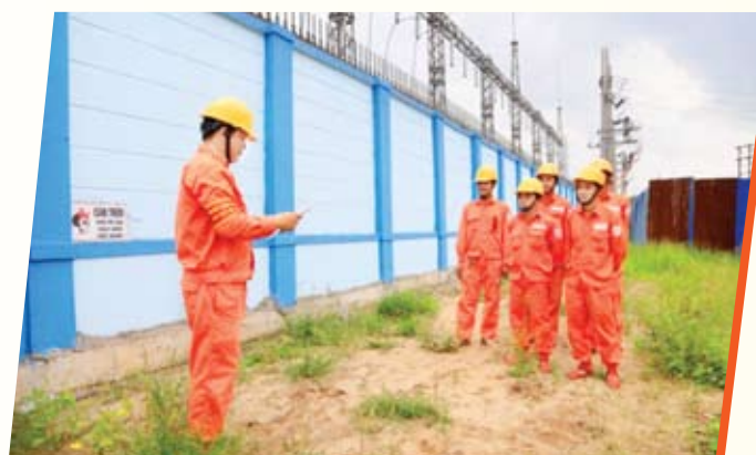
Đội đường dây Công ty Lưới điện Cao thế TP. Hà Nội tăng cường kiểm tra sửa chữa đường dây 110KV cấp điện cho các trọng điểm.
