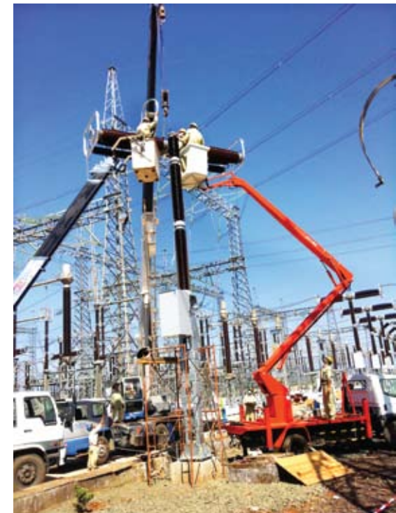
Công nhân EVNNPT tích cực sửa chữa đường dây và trạm biến áp đảm bảo cung cấp điện phục vụ nhu cầu dân sinh và phát triển kinh tế xã hội của đất nước.
