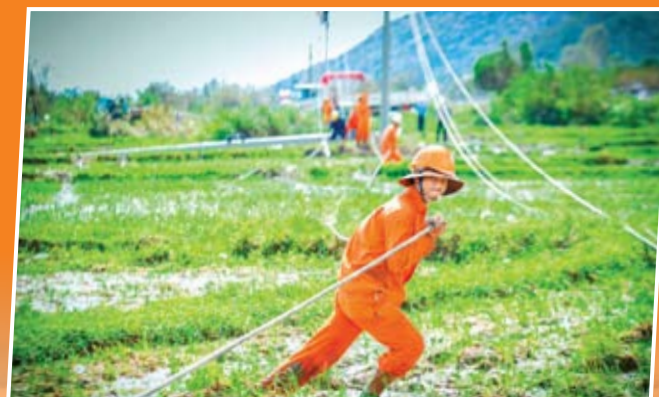
Công nhân Công ty Điện lực Đắk Lắk kéo dây khắc phục sự cố lưới điện do mưa bão gây ra
