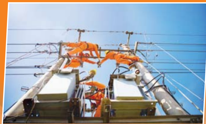
Công nhân Điện lực Krông Năng - Công ty Điện lực Đắk Lắk thay Cầu chì tự rơi (FCO) bảo vệ Máy biến áp.
