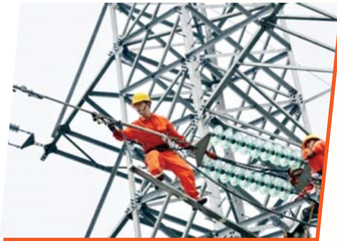
Công nhân Đội đường dây Công ty Lưới điện Cao thế TP. Hà Nội đang xử lý sự cố lưới điện cao thế.
