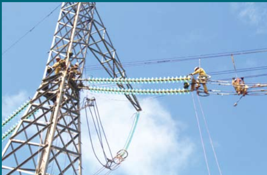
CNLD Tổng công ty Truyền tải Quốc gia đang sửa chữa đường dây 500kV.
