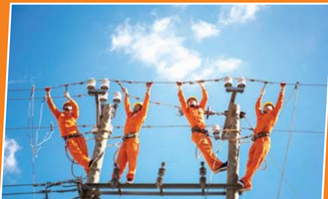
Công nhân Công ty Điện lực Đắk Lắk đang đấu nối Trạm biến áp
