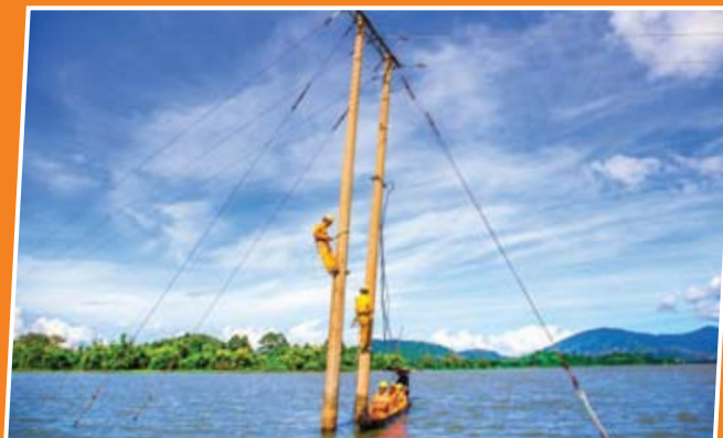
Công nhân Công ty Điện lực Đắk Lắk khắc phục sự cố lưới điện do mưa bão gây ra
