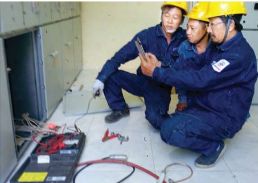
Anh Chi cùng anh em trong tổ đang đo các thông số điện tại trạm biến áp Văn Duyệt ở đường CMT8, Quận 3, TP Hồ Chí Minh.
