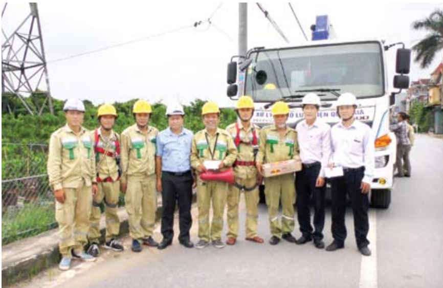
Vất vì vì luôn phải vất vẻo trên cột điện, nhưng công nhân Truyền tải điện Hà Nội luôn nhận được sự quan tâm kịp thời của cán bộ công đoàn Công ty Truyền tải điện 1.
