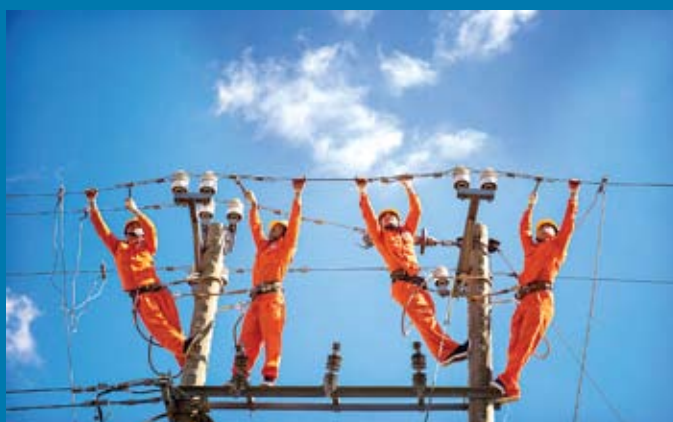
Ảnh số 2 - “Vũ điệu người thợ điện” - Tác giả Nguyễn Ngô Bảo Ngọc (Công ty Điện lực Đắk Lắk).
