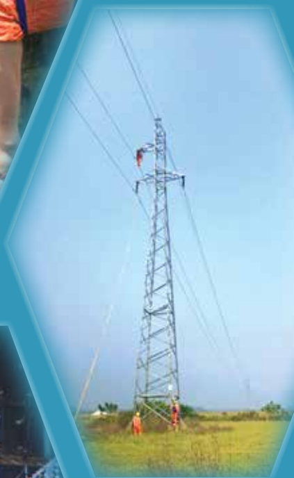
Những người thợ đường dây Công ty điện lực Hà Tĩnh.
