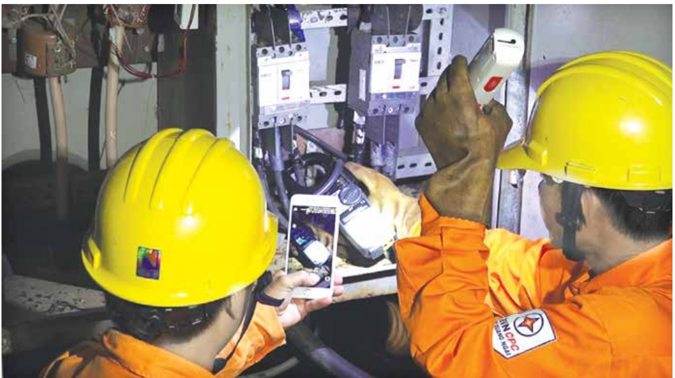
Anh Thi kiểm tra hệ thống tủ điện Trạm biến áp Sơn Dung 6.
