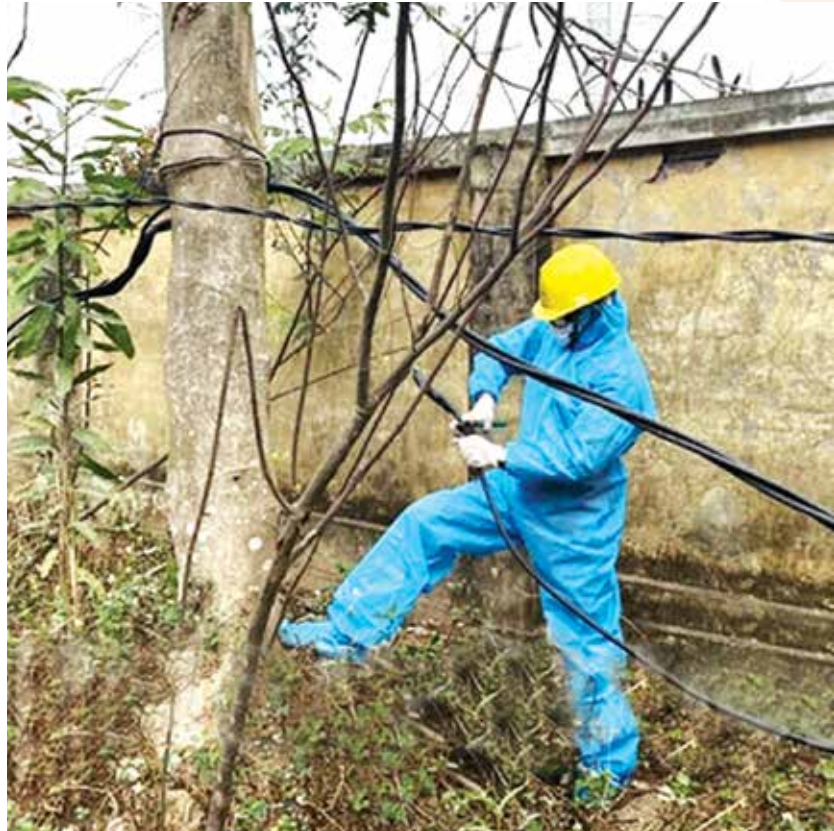
Công nhân Điện lực Chí Linh kiểm tra đường điện bảo đảm phục vụ điện cho bệnh viện dã chiến.
