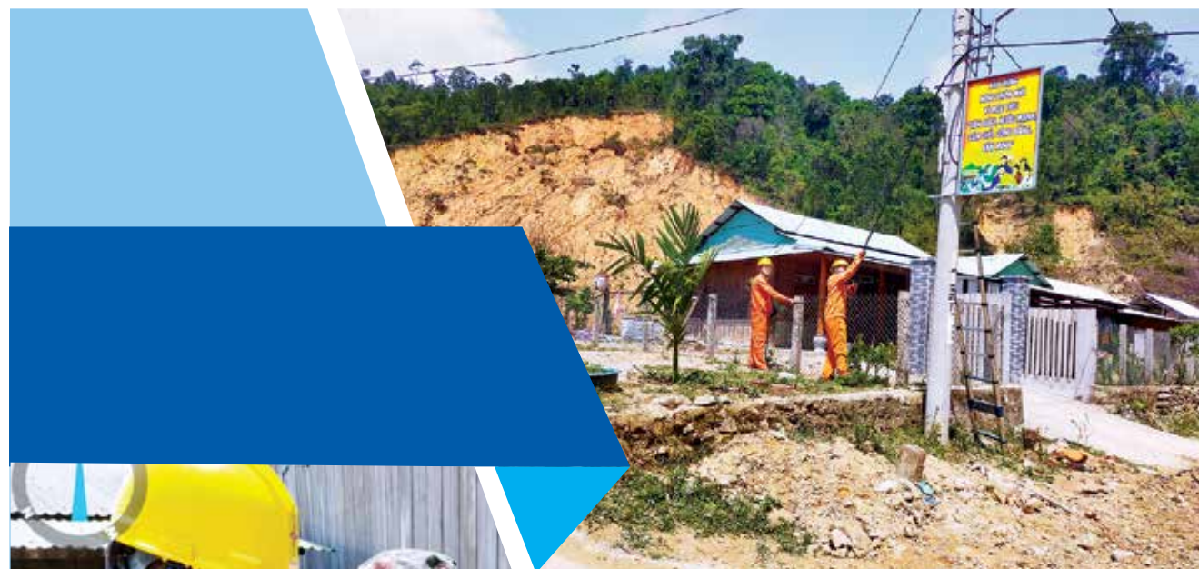
Công nhân chuẩn bị vật tư, thiết bị để lắp đặt
