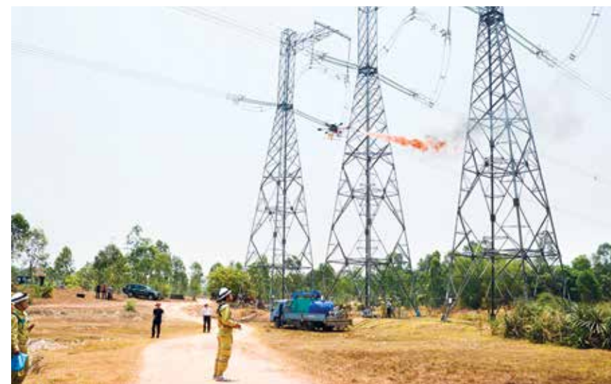
Cán bộ Phòng Kỹ thuật Công ty Truyền tải Điện 2 (PTC2) đang điều khiển UAV sáng chế xử lý sự cố trên đường dây 500 kV. Ảnh: EVNNPT
