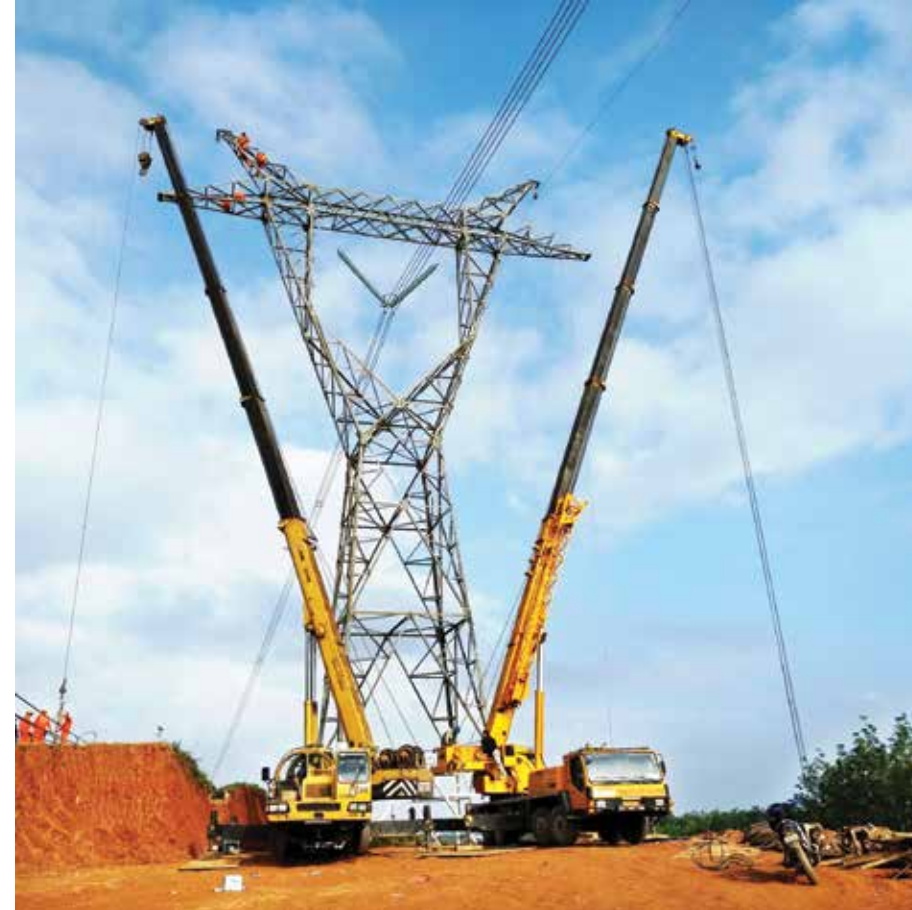
Thi công nâng cột
