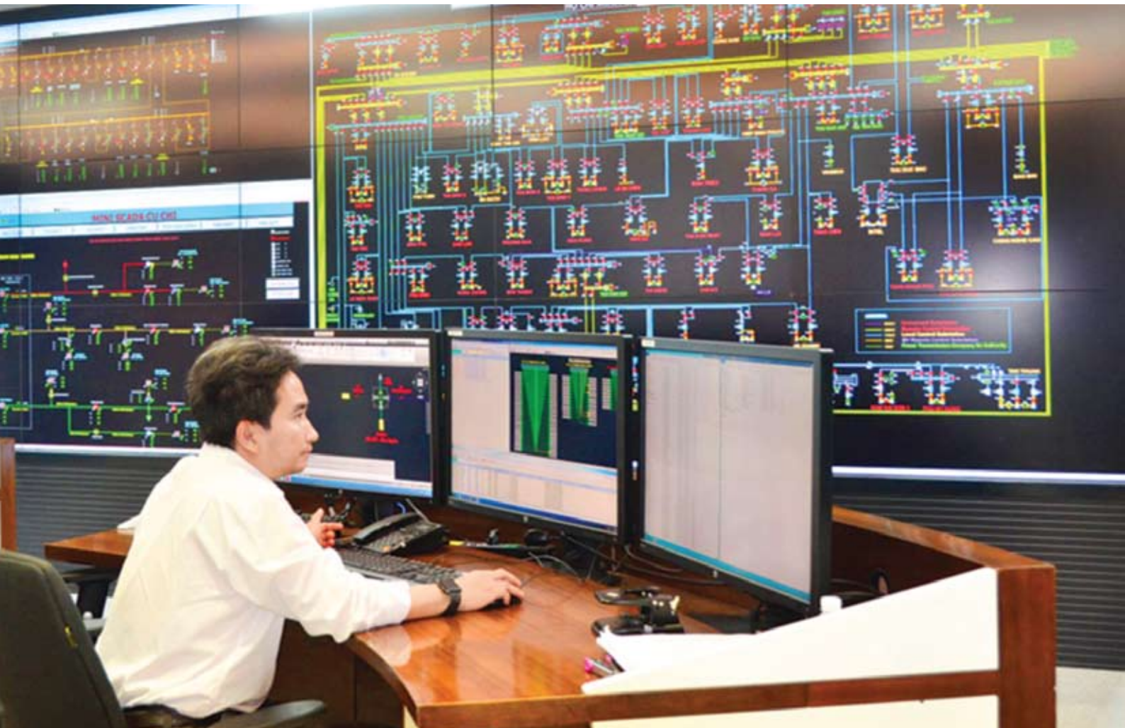
Trung tâm điều khiển xa của Tổng công ty Điện lực TP.HCM.
