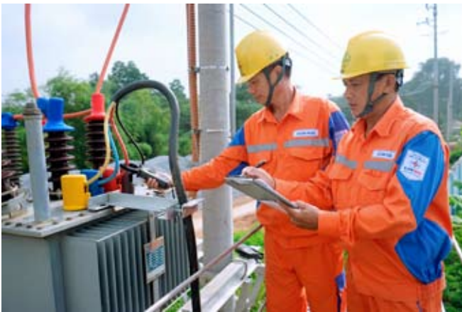
Đội trưởng Kiều Anh Tuấn (người cầm sổ) đang thực hiện ghi chép thông số kỹ thuật tại trạm biến áp
