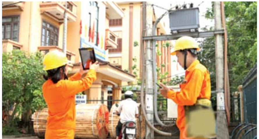
Vận hành hệ thống điều khiển tự động lưới điện.
