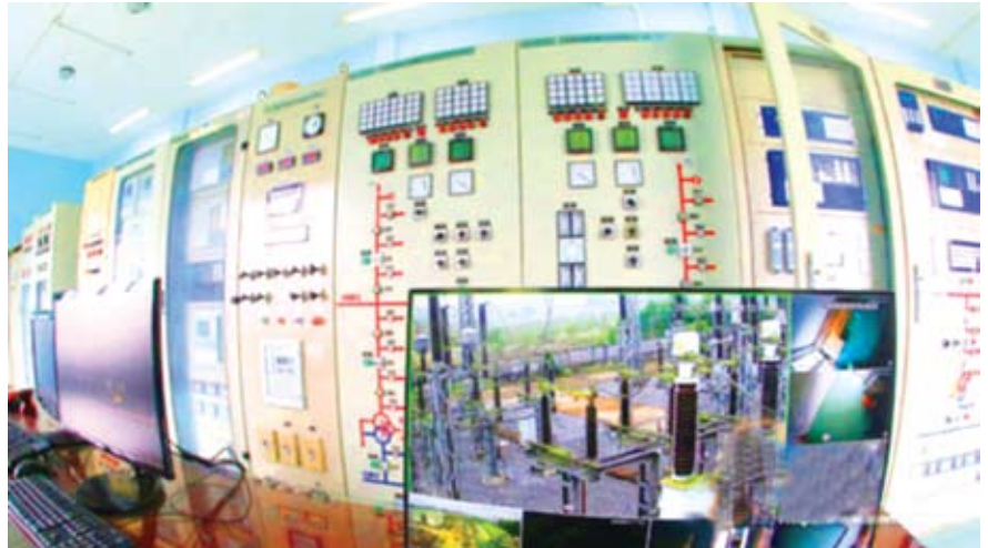
Một trong 7 trạm biến áp 110KV không người trực trên địa bàn tỉnh Quảng Trị do Công ty Điện lực Quảng Trị quản lý, vận hành
