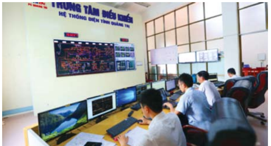
Hệ thống lưới điện trên địa bàn tỉnh Quảng trị được quản lý và vận hành tại Trung tâm điều khiển.
