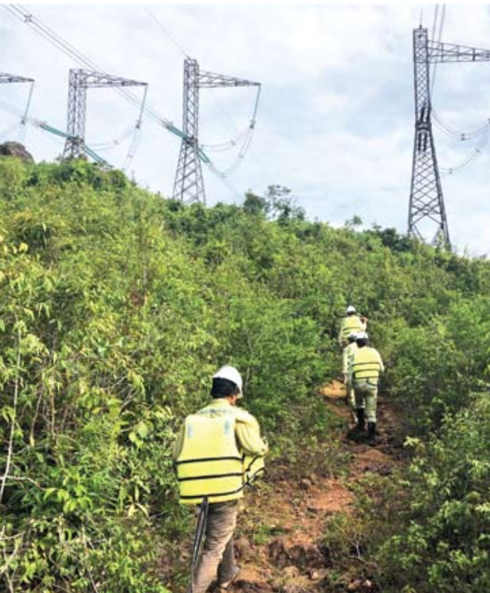
Công nhân tiếp cận một vị trí cột để kiểm tra, rà soát sau mưa lũ.
