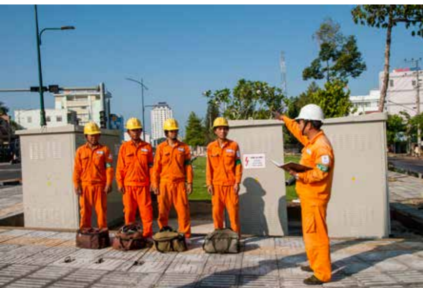
Tăng cường công tác kiểm tra an toàn lao động tại hiện trường.
