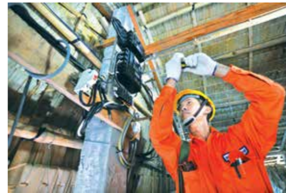
Thực hiện kiểm tra, bảo dưỡng thiết bị.
