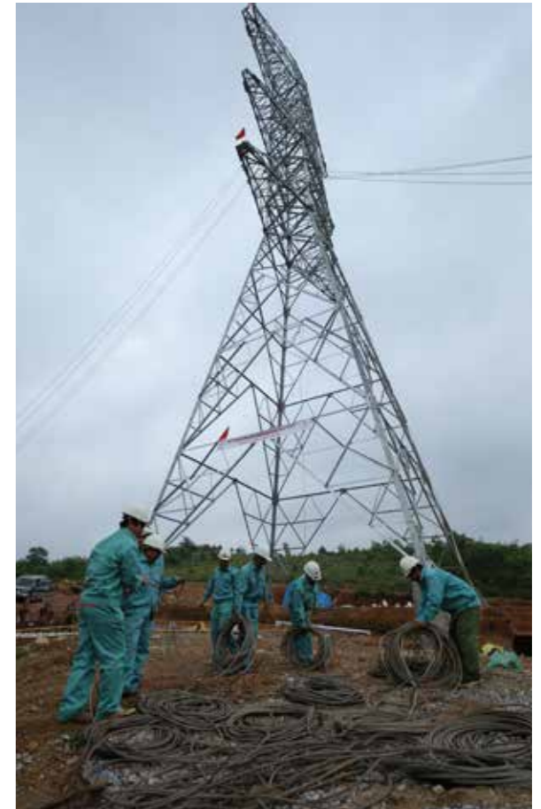
Các nhà thầu thi công kéo dây khoảng cột 270 - 277 ĐZ 500kV mạch 3 Quảng Trạch - Đốc Sỏi.
