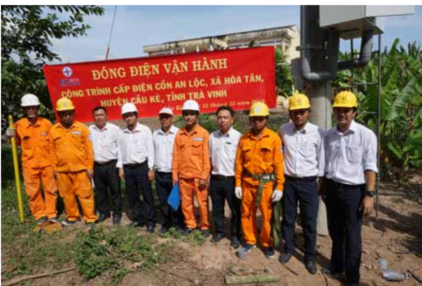
Lễ đóng điện vận hành công trình cấp điện cồn An Lộc huyện Cầu Kè (tháng 12/2018).
