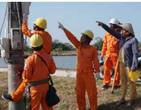
Công nhân Điện lực Châu Thành kiểm tra sửa chữa điện cho các hộ dân ấp Cồn Phụng.
