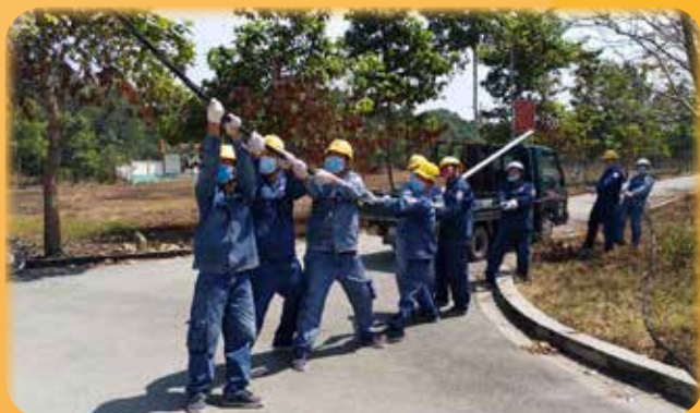
Điện lực Củ Chi thuộc Tổng công ty Điện lực HCM kéo điện cấp cho bệnh viện dã chiến phòng chống dịch Covid-19.
